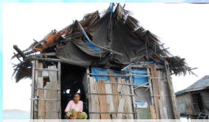
Rumah tidak layak huni di Permukiman Nelayan - Labuan Bajo,
