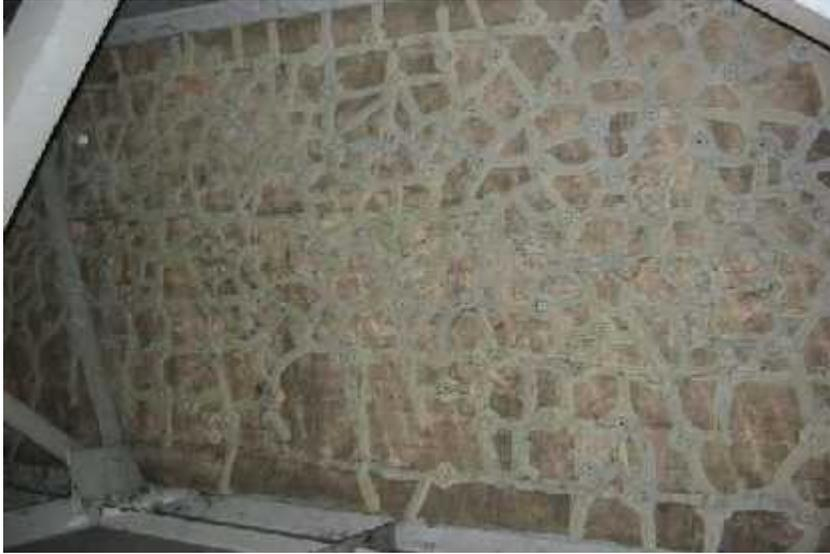
Gambar 9 – Penanganan Lantai Beton yang Retak
