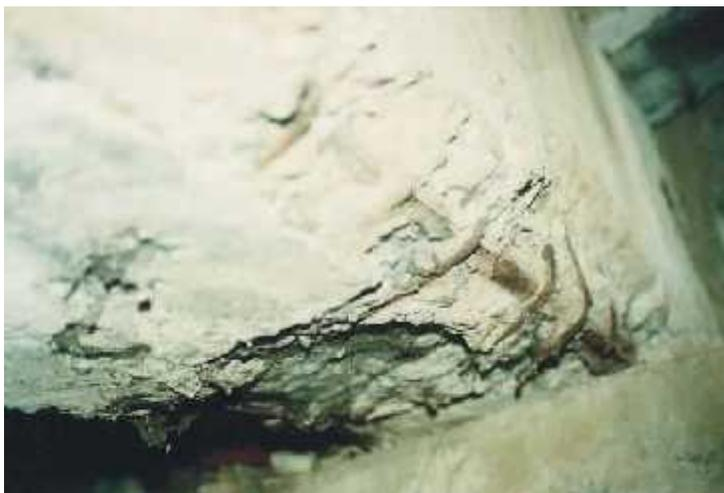
Gambar 10 – Korosi Baja Tulangan pada Beton
