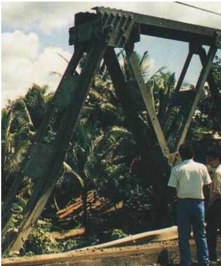
**Gambar 14 – Elemen Baja yang Mengalami Perubahan Bentuk**
