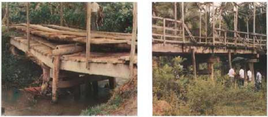
Gambar 18 – Jembatan Kayu yang Mengalami Kerusakan
