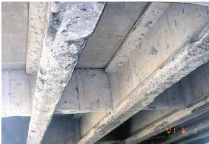
**Gambar 11 – Pecahnya Sebagian Beton pada Elemen Jembatan**
