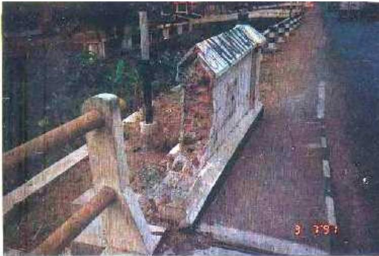
**Gambar 3 – Elemen Pasangan Bata pada Jembatan yang Pecah atau Hilang**
