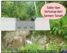
S. Telu di hulu Bendungan Tukul
