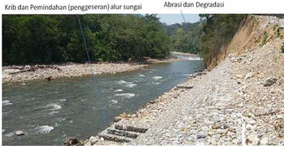
Gambar 54. Penanganan Abrasi pada Longsor Jalan ditepi Sungai
