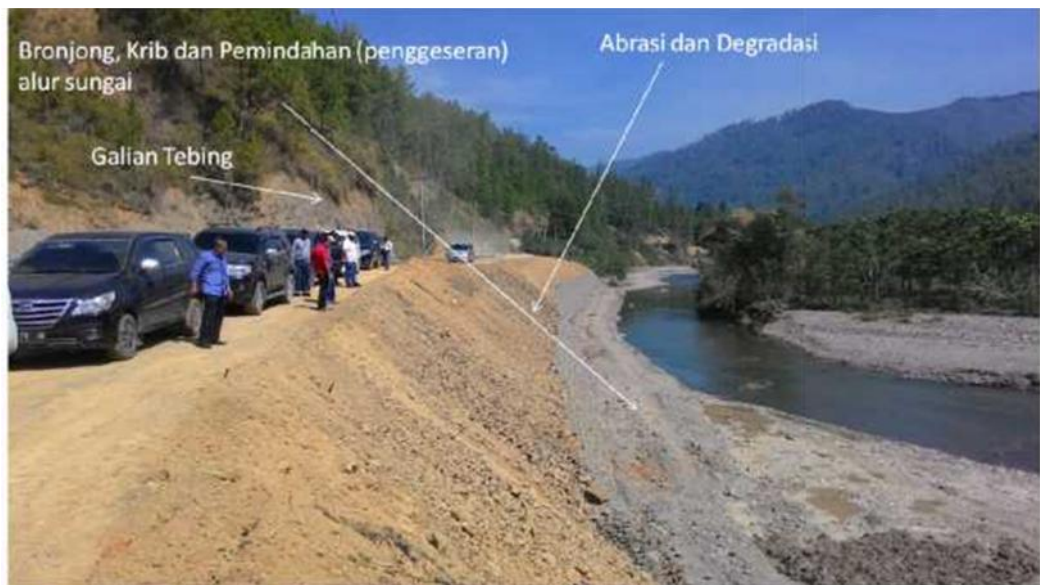
Gambar 55. Penanganan jalan akibat abrasi pada sungai tikungan dengan memindah palung sungai dengan memasang krib dan pelebaran kearah tebing setelah kondisi batuan dasarnya diketahui.
