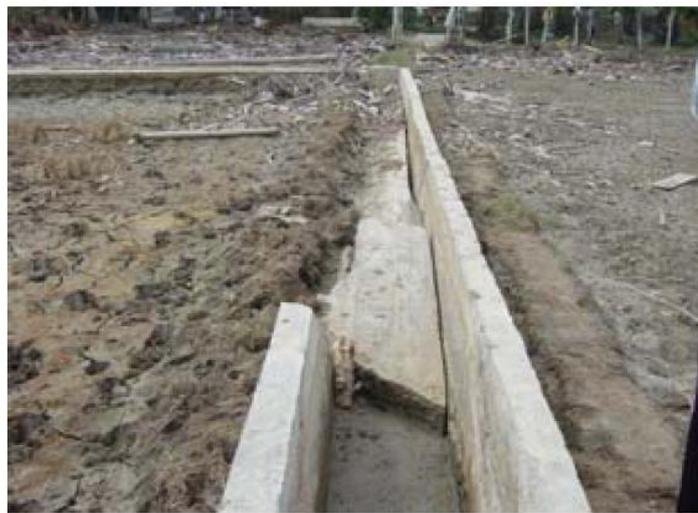
**Gambar 2.1. Saluran Irigasi Yang Rusak Akibat Bencana Tsunami Provinsi NAD (Sumber: K Subagyo)**
