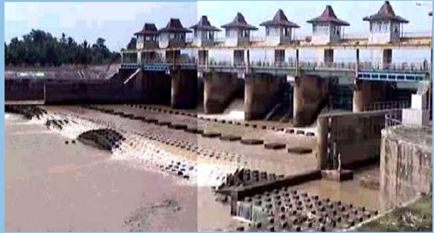
Bendung Pamarayan, Banten
