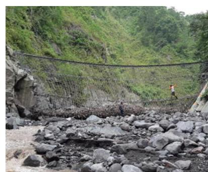
Sabo dam jaring kawat baja adalah teknologi sabo berupa bangunan penghalang aliran debris menggunakan cincin kawat baja yang dirangkai menjadi jaring sangat kuat tetapi fleksibel. Sabo dam jaring kawat baja mampu menahan aliran dan benturan bongkah dan puing batuan dari hulu.
