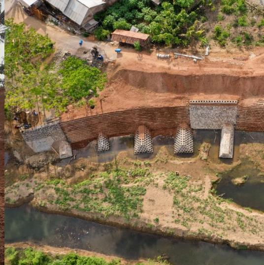
Pelindung tebing beton modular berkait atau *Interlocking Permeable Revetment* (IPR) adalah salah satu teknologi pelindung tebing sungai berupa boks-boks beton berlubang yang dirangkai dengan sistem terkunci (*interlocking*) dengan kemiringan lereng tertentu yang memungkinkan vegetasi untuk hidup
