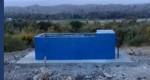
Teknologi Embung Sederhana berfungsi menampung air hujan untuk pemenuhan domestik dan irigasi pada daerah minim air.
