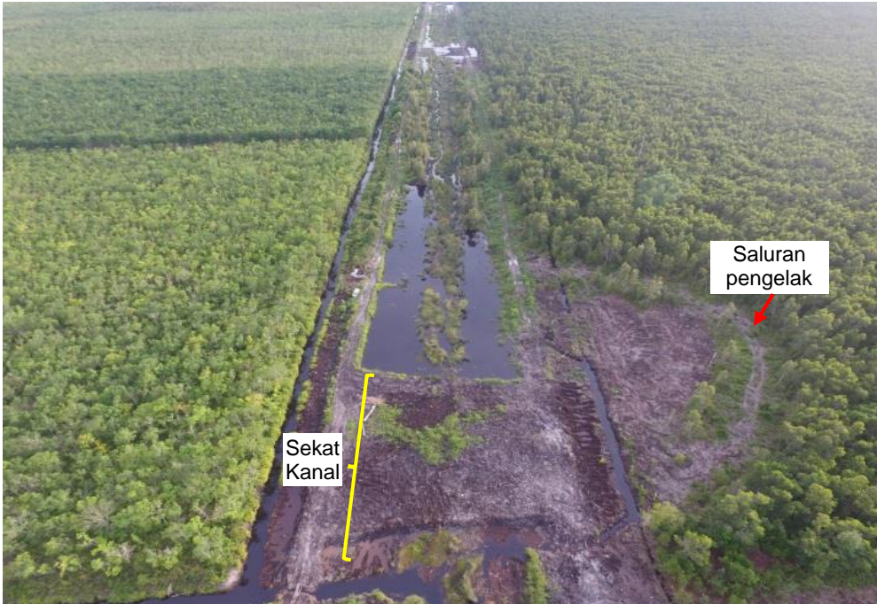
Gambar 17. Gambar konstruksi sekat kanal tipe back filling
