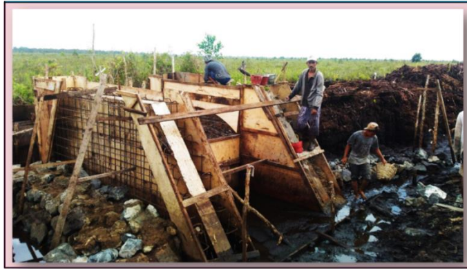
Gambar 28. Dokumentasi pemasangan bekisting
