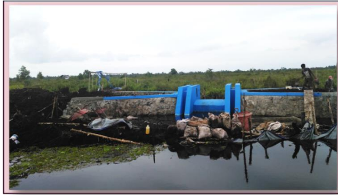
Gambar 32. Dokumentasi pekerjaan perapihan dan pengecatan
