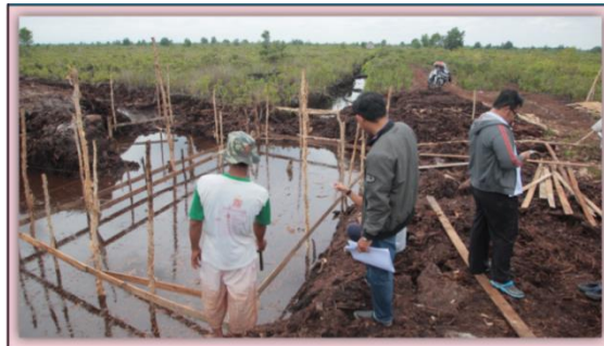
Gambar 22. Dokumentasi Pemasangan bowplank
