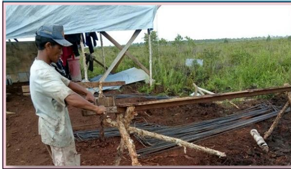
Gambar 26. Dokumentasi penyiapan besi tulangan
