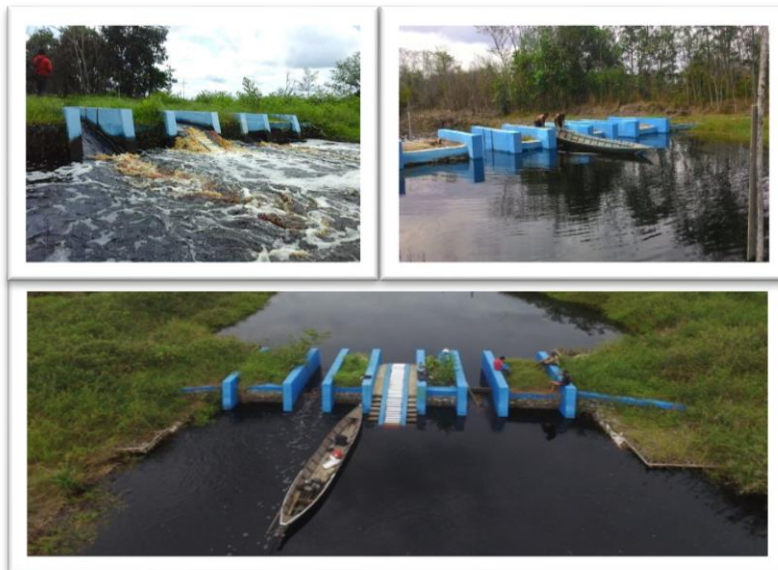
Gambar 18. Gambar konstruksi sekat kanal drainpile yang telah dibangun di daerah Sei Ahas, Kalimantan Tengah
