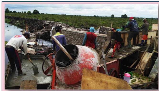
Gambar 29. Dokumentasi pekerjaan pementonan
