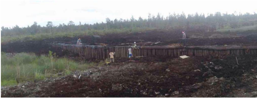
Gambar 12. Kegiatan konstruksi sekat kanal tipe kelapa
