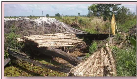
Gambar 24. Dokumentasi kayu galam untuk pondasi cerucuk
