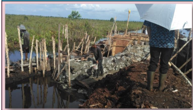
Gambar 30. Dokumentasi pekerjaan pemasangan batu
