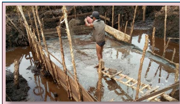
Gambar 25. Dokumentasi pembuatan lantai kerja
