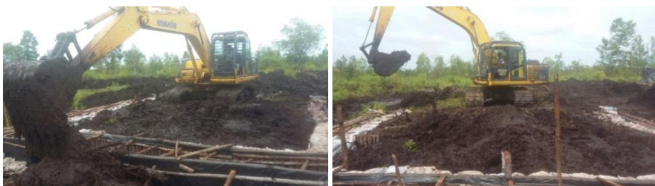
Gambar 11. Proses pemadatan menggunakan track roda ekskavator dan memukul-mukul bucket alat berat selama proses penimbunan berlangsung
