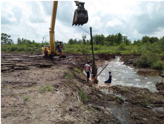
Gambar 8. Alat pemancang kayu tumih manual yang dilakukan dengan cara menumbuk salah satu ujung kayu. Ekskavator pemancang kayu yang dilakukan dengan cara menekan salah satu ujung kayu.
