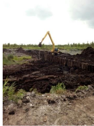
Gambar 8. Alat pemancang kayu tumih manual yang dilakukan dengan cara menumbuk salah satu ujung kayu. Ekskavator pemancang kayu yang dilakukan dengan cara menekan salah satu ujung kayu.
