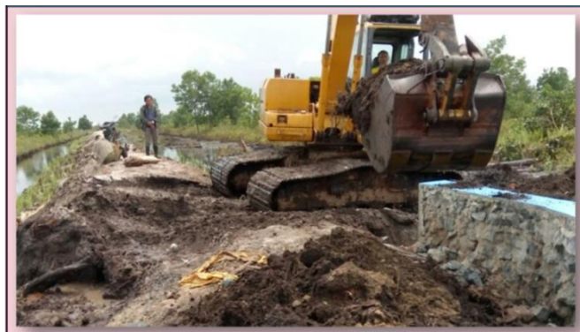
Gambar 31. Dokumentasi pekerjaan pengisian tanah urugan
