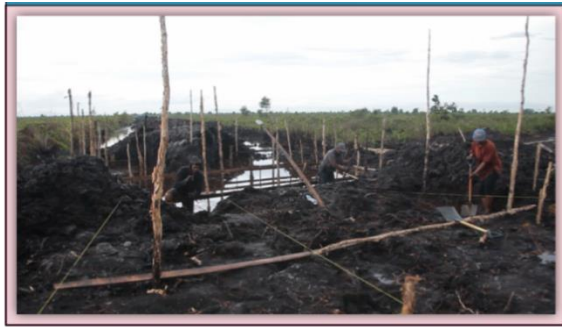
Gambar 23. Dokumentasi penyiapan lokasi kerja
