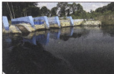
Gambar 7: Canal blocking yang dibangun di saluran rawa
