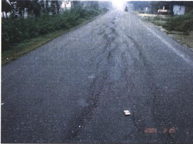
Gambar 5.14 Contoh Penurunan Perkerasan Jalan
